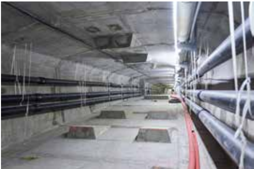
A7 intérieur du viaduc. VINCI Autoroutes © Jean-Philippe Moulet
