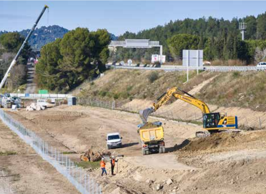
Terrassements de la future bretelle d’entrée sur A7.
