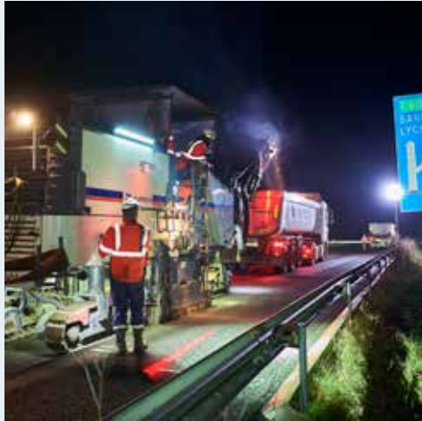
Faire du neuf avec du vieux, c’est une des solutions mises en place pour décarboner l’autoroute. L’objectif est de réutiliser les anciennes chaussées pour les remettre dans les nouvelles, limitant ainsi le recours à des matériaux naturels, ainsi que les émissions de CO 2 pour leur transport.
