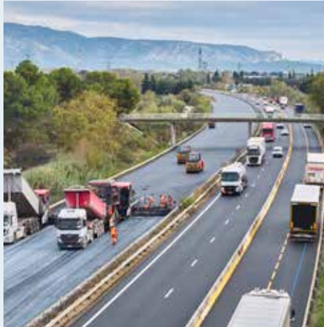
Faire du neuf avec du vieux, c’est une des solutions mises en place pour décarboner l’autoroute. L’objectif est de réutiliser les anciennes chaussées pour les remettre dans les nouvelles, limitant ainsi le recours à des matériaux naturels, ainsi que les émissions de CO 2 pour leur transport.
