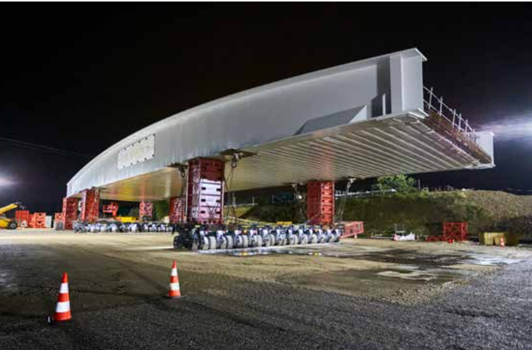
La pré-construction de la charpente métallique du nouveau pont a duré pendant huit mois en usine puis à proximité de son futur emplacement. La nuit du samedi 12 au 13 octobre 2024, le nouveau pont a été déplacé sur des remorques et installé à la place de l'ancien pont. Cette opération a été conduite par 45 ouvriers qui ont installé au-dessus de l'A7 les 454 tonnes de la structure. Les opérations de bétonnage, d'étanchéité, la réalisation des enrobés définitifs et de la signalétique sont engagées pour préparer sa réouverture début 2025. VINCI Autoroutes © Jean-Philippe Moulet
