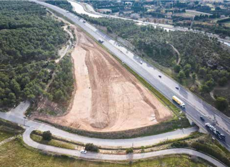
Terrassements au niveau de la future bretelle de sortie d’A7.
