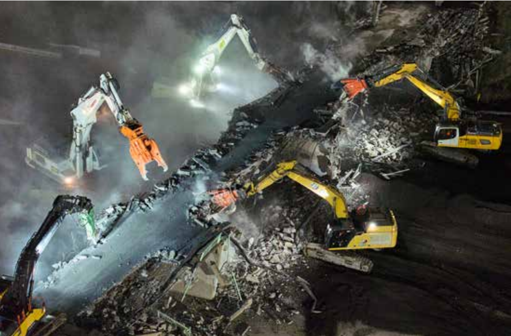
En réponse à l'élargissement de la plateforme autoroutière de l'A7, le pont qui l'enjambe et sur lequel passe la D68 a dû être remplacé par un autre, plus long et plus large. Le samedi 16 mars 2024, à partir de 21 heures, 60 ouvriers, avec d'énormes camions Dumper et dix pelleteuses, dont certaines hautes de 4 m, étaient mobilisées pour s'attaquer au grignotage du tablier et des piles, puis pour débiter les 550 m³ de débris produits, qui ont été réutilisés et recyclés. À 7 heures, la circulation reprenait. VINCI Autoroutes © Jean-Philippe Moulet
