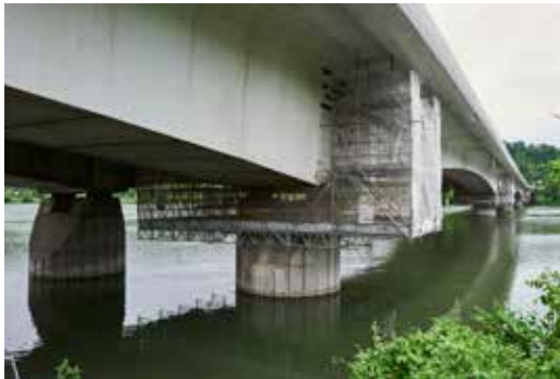
A7 viaduc de Vienne. VINCI Autoroutes © Jean-Philippe Moulet
