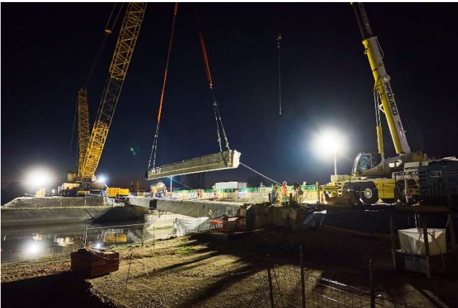
La grue de 77 m de hauteur dépose les 12 poutres, de 90 tonnes chacune, composant l'ancien tablier du pont. © J-P Moulet pour VINCI Autoroutes
