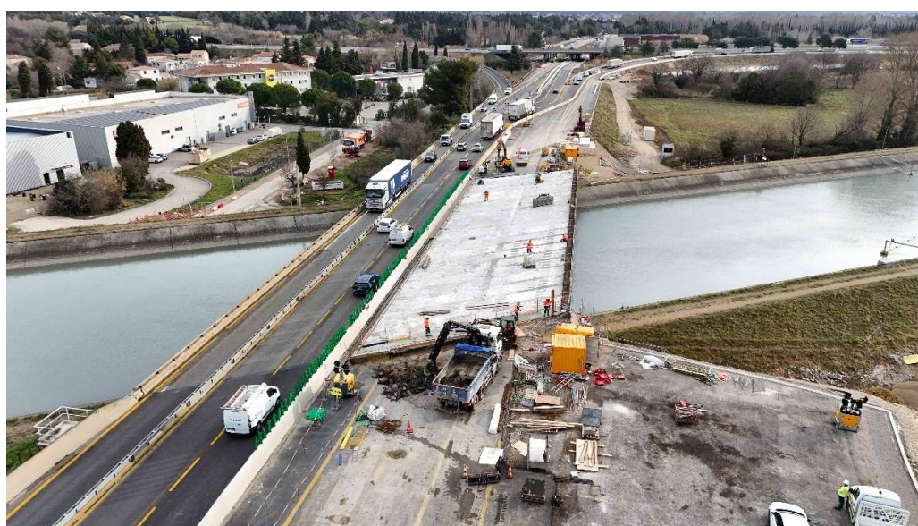
La pose des dalles du tablier du nouvel ouvrage © J-P Moulet pour VINCI Autoroutes
