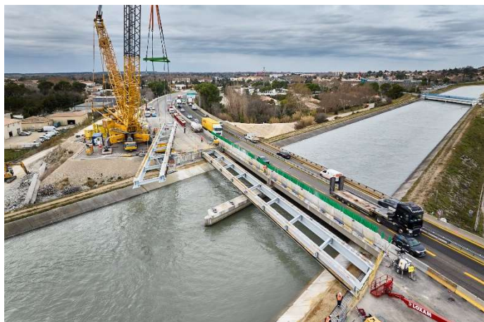
La pose de la charpente du nouvel ouvrage © J-P Moulet pour VINCI Autoroutes
