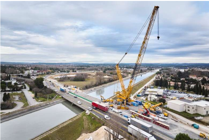
La déconstruction du tablier de l'ancien ouvrage © J-P Moulet pour VINCI Autoroutes
