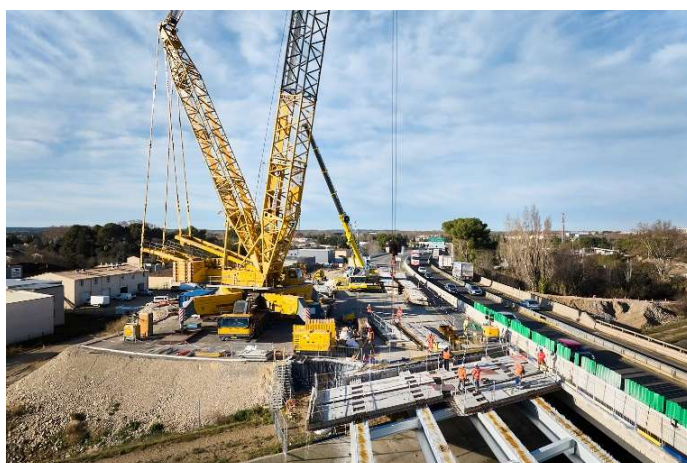
La pose des dalles du tablier du nouvel ouvrage © J-P Moulet pour VINCI Autoroutes
