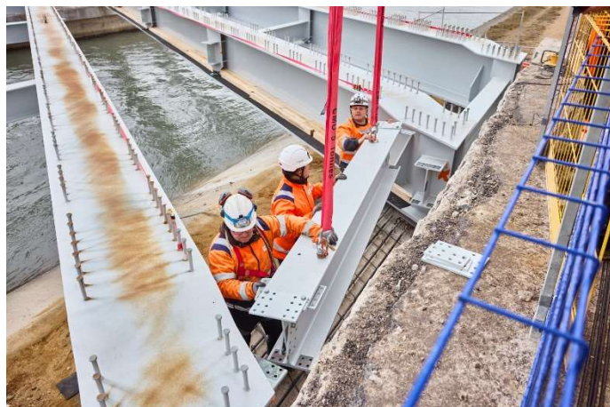
La pose de la charpente du nouvel ouvrage © J-P Moulet pour VINCI Autoroutes
